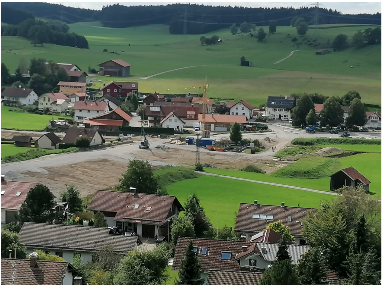
Baustelle zwischen den Ortsteilen Oberzell (im Hintergrund) und Stocken (im Vordergrund)
