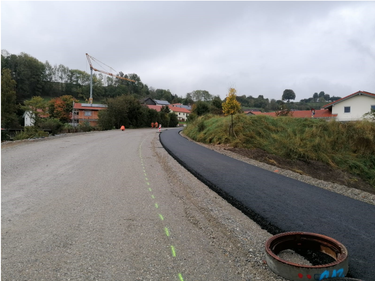
der neue Geh- und Radweg entsteht
